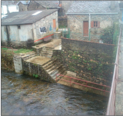
Figura 7. La línea roja marca hasta donde llegó la lámina de agua en el evento sucedido en enero de 2013 según un testimonio recogido.
