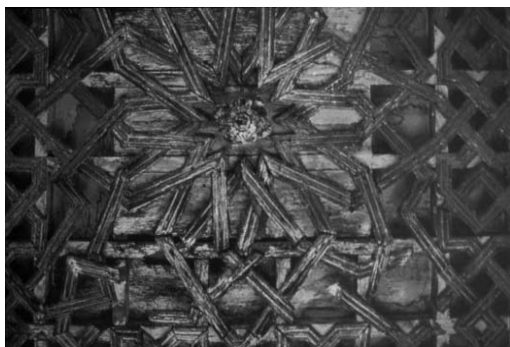
Figura 6. Cubierta del claustro del monasterio franciscano de Tzintzuntzan (México). Siglo XVI.
