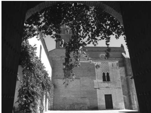
Figura 1. Fachada del antiguo palacio del Rey don Pedro, luego monasterio de Santa Clara, en Tordesillas (Valladolid) donde permaneció en cuerpo de Felipe el Hermoso hasta su traslado a la Capilla Real de Granada. Siglo XIV.
