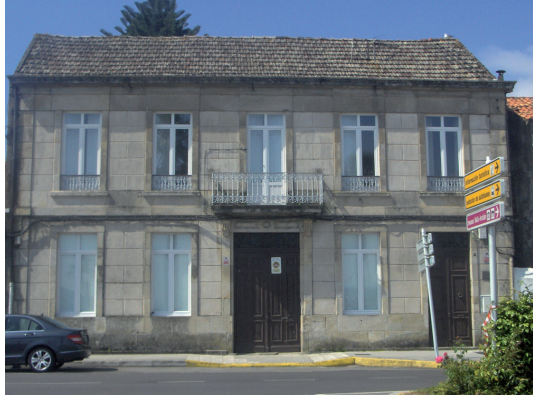
Figura 7. Construcción del Paseo del Arenal, nº. 3.. Pobra do Caramiñal.
