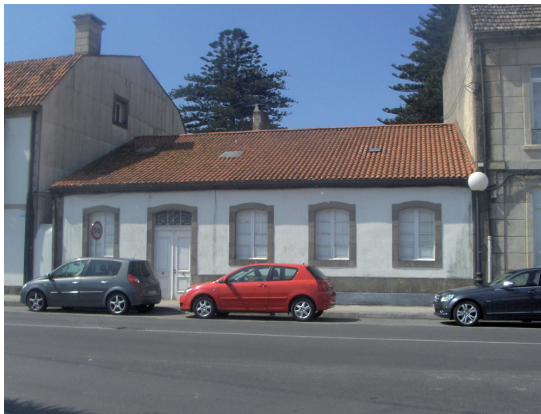
Figura 5. Construcción del Paseo del Arenal, n.º. 4. Pobra do Caramiñal.
