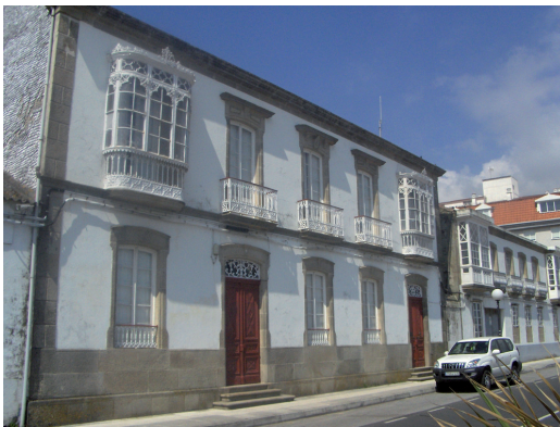
Figura 10. Construcción del Paseo del Arenal, nº. 18. Pobra do Caramiñal.
