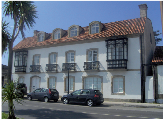
Figura 8. Construcción del Paseo del Arenal, nº. 5-6.. Pobra do Caramiñal.
