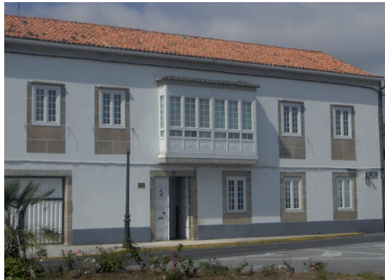
Figura 6. Construcción del Paseo del Arenal, n.º. 2.. Pobra do Caramiñal.
