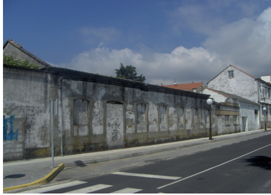
Figura 3. Construcción del Paseo del Arenal, nº. 18-20. Pobra do Caramiñal.
