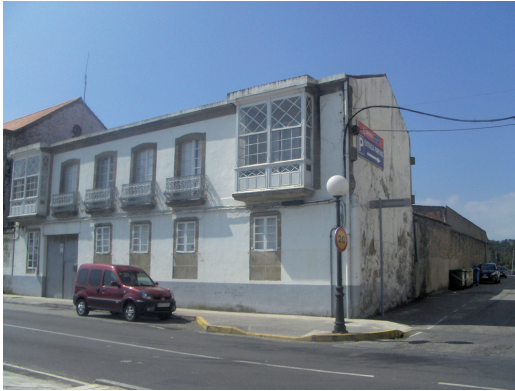
Figura 9. Construcción del Paseo del Arenal, nº. 17. Pobra do Caramiñal.
