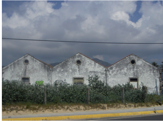
Figura 12. Construcción del Paseo del Arenal, s/n. Pobra do Caramiñal.
