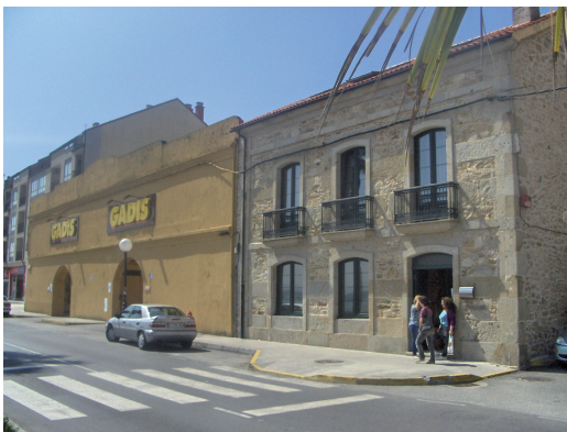
Figura 11. Construcción del Paseo del Arenal, nº. 7. Pobra do Caramiñal.
