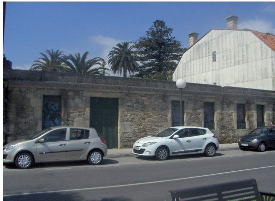
Figura 4. Construcción del Paseo del Arenal, s/n.. Pobra do Caramiñal.
