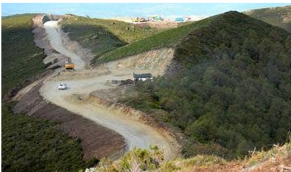
Figura 13.- Fase constructiva del Parque Eólico de la Sierra do Orbio (Lugo) con afección muy significativa sobre hábitats de interés comunitario. Fotografía: Europa Press: 2018
