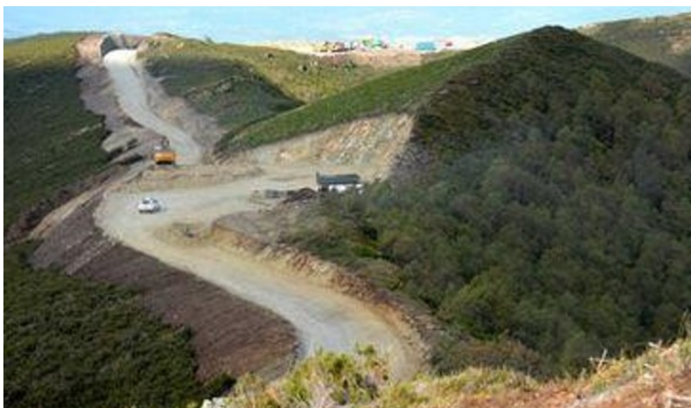
Figura 13.- Fase constructiva del Parque Eólico de la Sierra do Orbio (Lugo) con afección muy significativa sobre hábitats de interés comunitario. Fotografía: Europa Press: 2018
