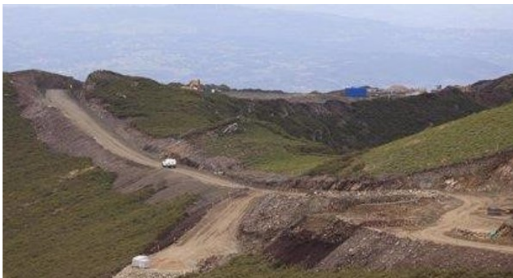
Figura 12.- Fase constructiva del Parque Eólico de la Sierra do Orbio (Lugo) con afección muy significativa sobre hábitats de interés comunitario. Fotografía: Europa Press: 2018
