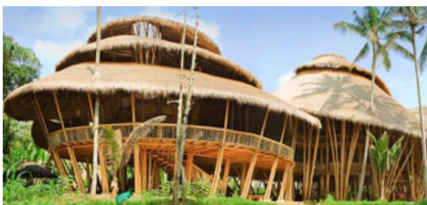
Imagen 7: Edificios principales Campus Greenschool
