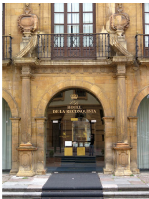
Fig. 19. Hospicio y hospital real de huérfanos, expósitos y desamparados (1752-1770) en Oviedo, hoy Hotel de la Reconquista. Calle central de la fachada principal
