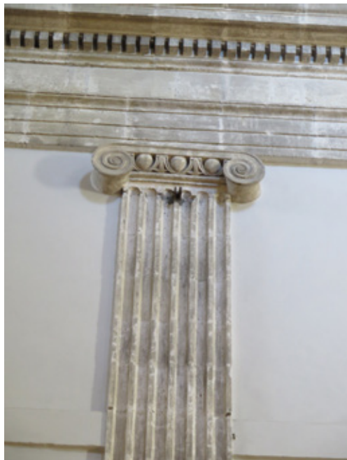
Fig. 7. Iglesia del monasterio de San Vicente (1587) en Oviedo. Detalle de una pilastra de la nave
