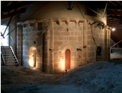
Fig. 2. Ábside mayor de la catedral de Mondoñedo visto sobre el trasdós de las bóvedas de la cabecera
