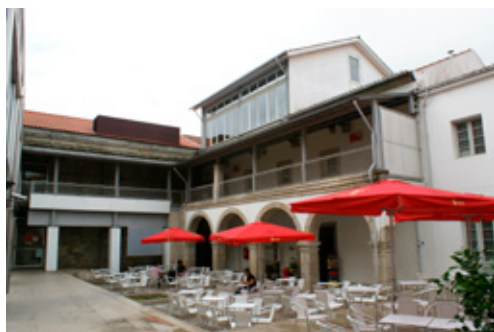
Fig. 2. Convento de Nossa Senhora do Terço (Barcelos, Portugal). Restos del claustro, transformado en patio-terracea del Centro Comercial do Terço
