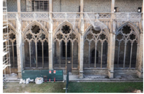
Fig. 15. Catedral de Pamplona. Claustro. Vista de la panda este desde el patio. Ca. 1280-1318. Fotografía de Marina Garzón Fernández
