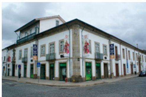
Fig. 1. Convento de Nossa Senhora do Terço (Barcelos, Portugal). Aspecto del exterior de sus dependencias en la actualidad
