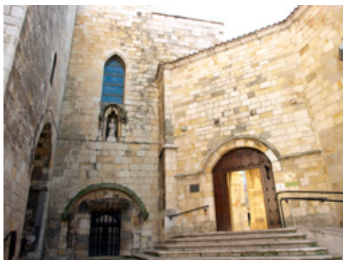
Fig. 1. Muro de cierre de la nave de Nuestra Señora de la Vela entre la torre y la puerta del claustro
