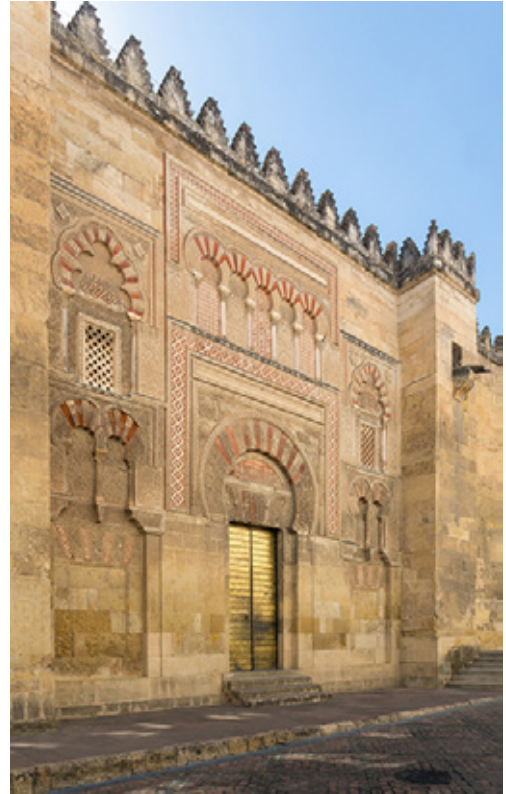
Fig. 12. Uno de los portales en la fachada este, restaurado y parcialmente reconstruido por Ricardo Velázquez Bosco, trabajando junto con el escultor Mateo Inurria, después de 1908
