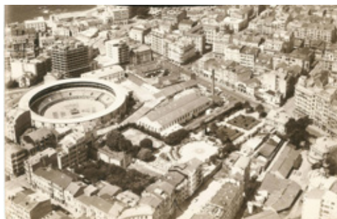
Fig. 2. Imagen del Ensanche de A Coruña – Web “Coruña Fotos Antiguas”
