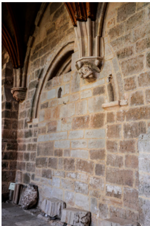
Fig. 6. Santa María de Sasamón. Claustro. Puerta primitiva de acceso al claustro tapiada por un arranque de la bóveda. Fotografía de la autora
