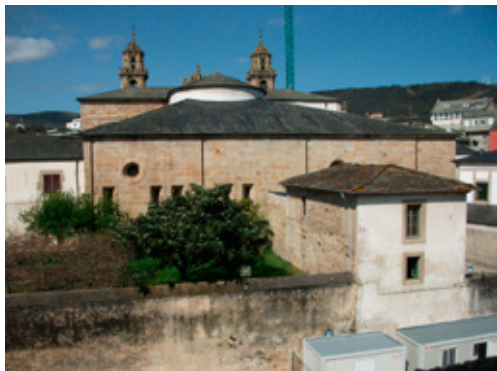
Fig. 7. Exterior de la cabecera de la catedral de Mondoñedo Santiago, abierta a su correspondiente capilla y cubierta por una bóveda de crucería.
