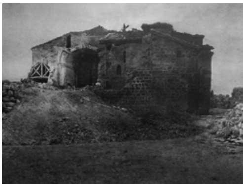
Fig. 4. Iglesia de San Vicente de Frías (Burgos). Tras la caída de la torre en 1906. Ayuntamiento de Frías
