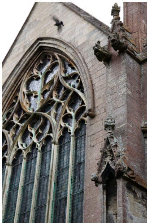
Fig. 9. Ventana oriental con tracería curvilínea, iglesia parroquial de Heckington, 1330-40 (autor)
