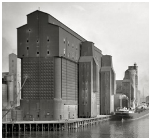
Fig. 1. Dakota elevator, Buffalo (1901, demolido en 1965); imagen de época, similar a la proyectada por Gropius en Monumentale kunst und industriebau en 1911, cuyo manuscrito subraya el potente efecto de su cuerpo central, con estructura metálica, pese al reducido espesor del cerramiento. Fuente: Detroit Publishing Co.
