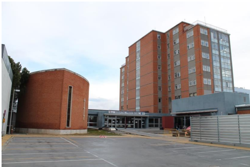
Fig. 8 Vista parcial del hospital desde el acceso principal
