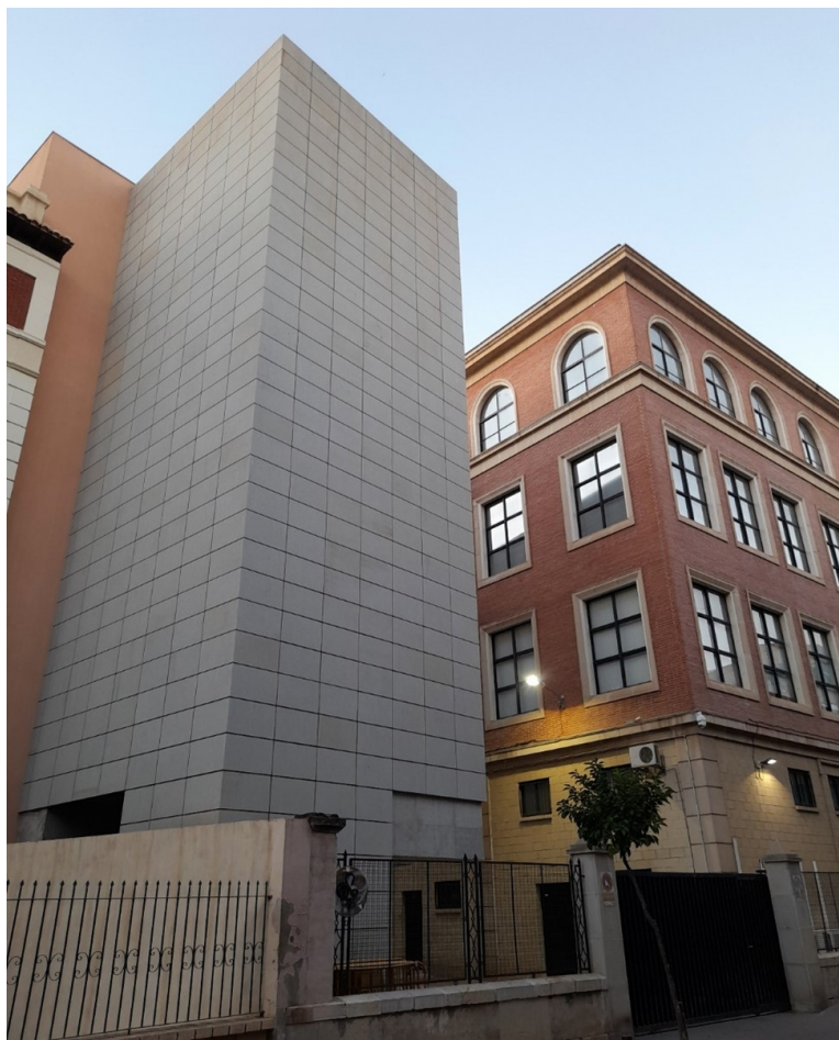
Fig. 12 Edificio Anexo de Derecho, J. A. Molina, J. L. de Arana y M. Aroca, Murcia, España.
