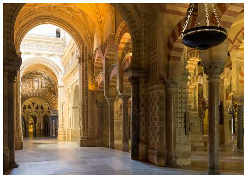
Fig. 8. La esquina noroeste del crucero en dirección sur hacia la ampliación de al-Hakam. Se pueden observar las bóvedas nervadas que distinguen la nueva intervención de la fábrica de la mezquita a su alrededor
