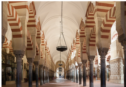
Fig. 10. Como parte de las bóvedas y lucernarios instalados en el siglo XVIII por todo el edificio, los que se aprecian en la fotografía se mantienen en la zona de la ampliación de al-Mansur
