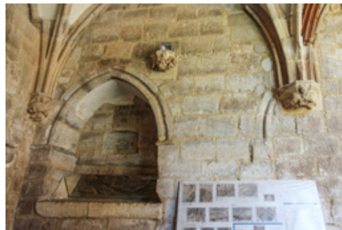
Fig. 5. Santa María de Sasamón. Claustro. Detalle de un arco-solio de la panda oeste tapiado por un arranque de la bóveda. Fotografía de la autora
