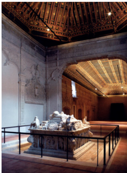
Fig. 7. Interior de la capilla mayor de San Ildefonso de Alcalá de Henares (Quintana Gordon, “Materia y significado,” 643)
