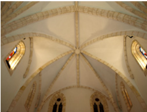
Fig. 11. Bóveda de la capilla mayor del monasterio jerónimo de Monte Corbán
