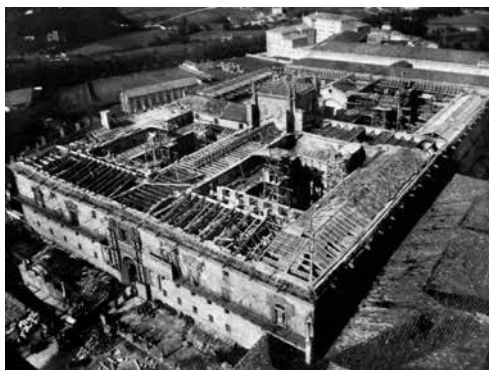
Fig. 10: Fernando Moreno Barberá, Julio Cano Lasso, Juan Gómez González de la Buelga y Rafael de la Joya Castro: Transformación en hotel del Hospital Real (1954). Vista de las obras. ( Revista Nacional de Arquitectura 156, 1954)
