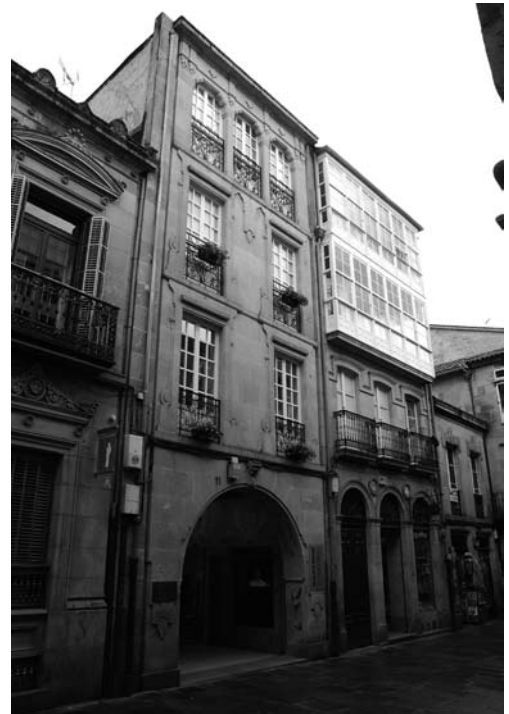
Fig. 14. Edificio en rúa do Vilar, 11. José María Banet, 1933 (Autor)
