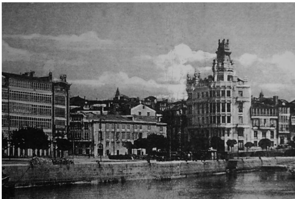
Fig. 9. Encuentro de la Marina con la Ciudad Vieja de A Coruña. A la izquierda la Casa Rey y a la derecha la Casa Molina (Catálogo de la colección de postales. Archivo Municipal, A Coruña, 1998)
