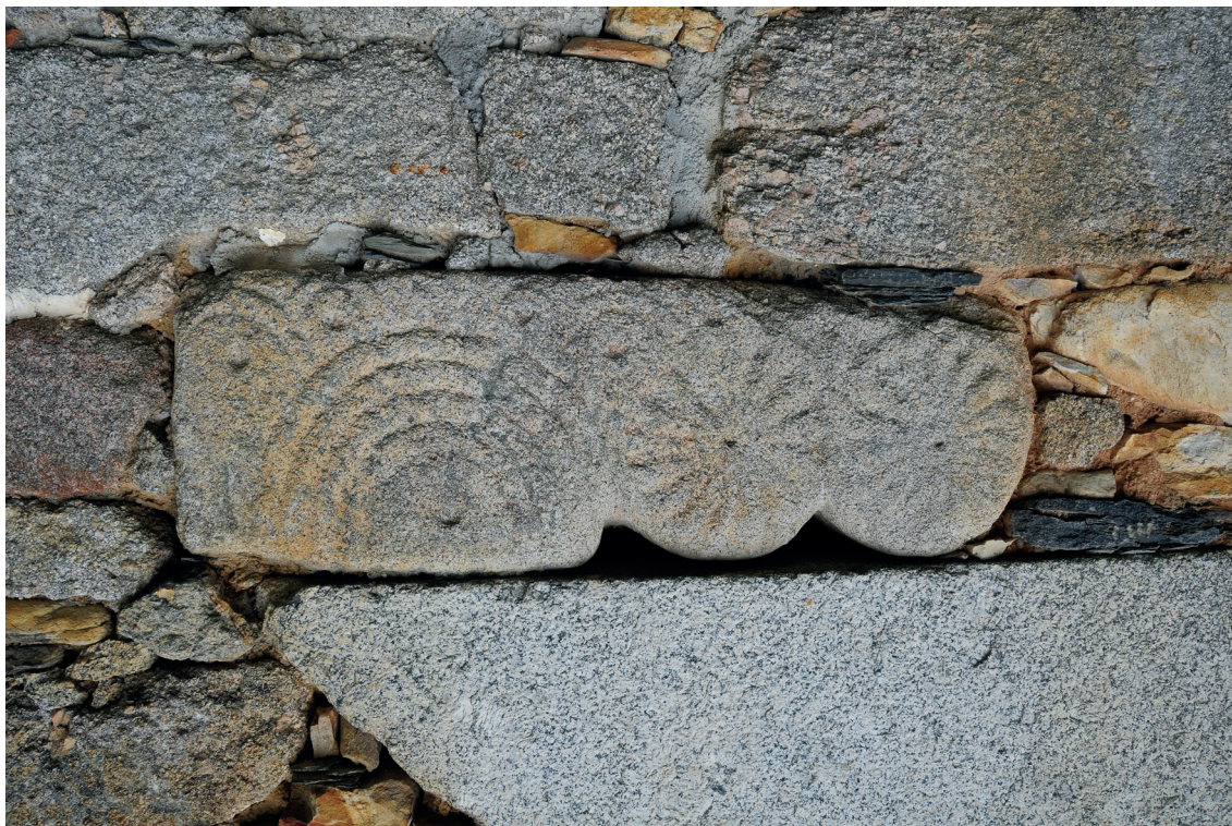
Figura 9. Modillón de rollos prerrománico empotrado en el muro exterior de una casa al sur de la iglesia. Fotografía de los autores.
