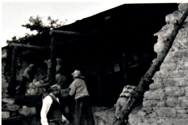
Figura 7. Trabajos de reconstrucción del muro norte de la iglesia por los vecinos de la aldea de Tórdea en los años 80 del siglo XX. Fotografía tomada del panel explicativo del interior del templo.
