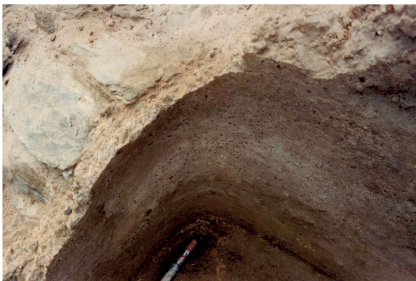
Figura 9. Detalle do opus caementicium do Tanque.
