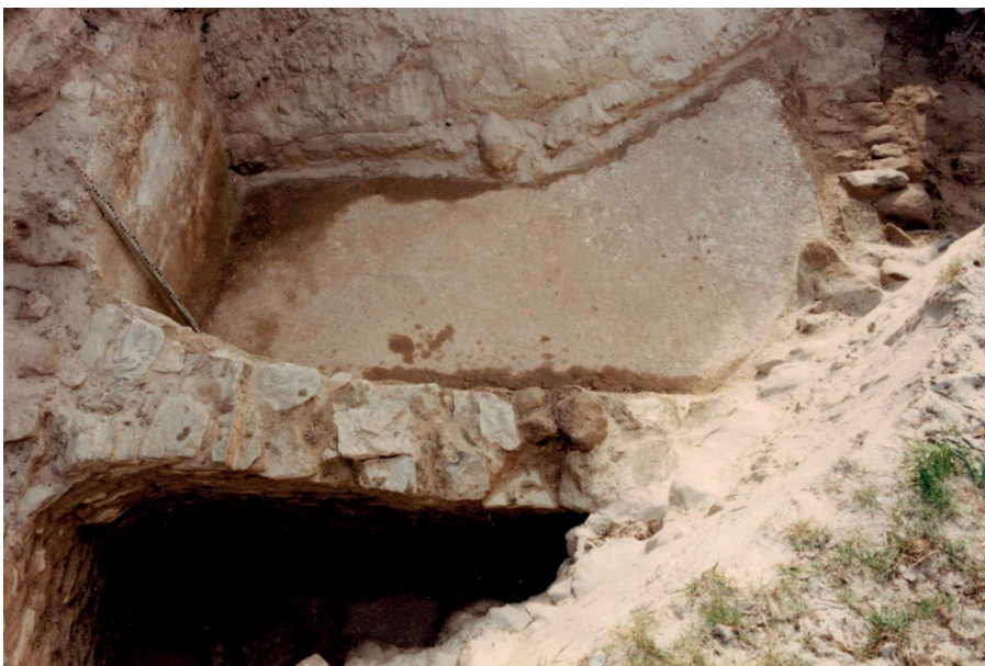
Figura 11. Detalle da diferenza de cota entre o Anexo, en primeiro termo, e o Tanque.
