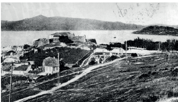
Figura 4. Foto de Pacheco de comezos do século XX, no que se observa o Castelo de San Sebastián sobre a cidade.
