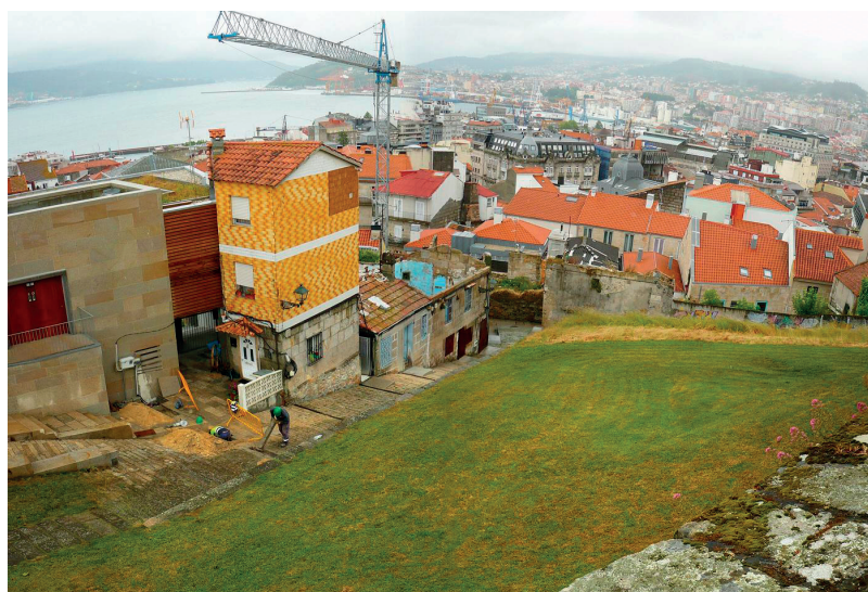
Figura 6. Vista das obras na rúa Hortas, dende o Castelo de San Sebastián.
