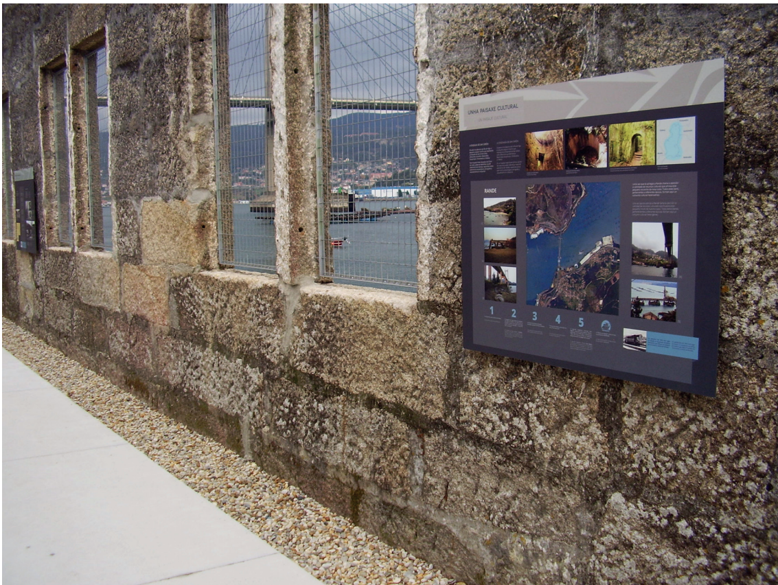
Figura 13. Colocación dun panel exterior de formato 100 x 120 cm.
