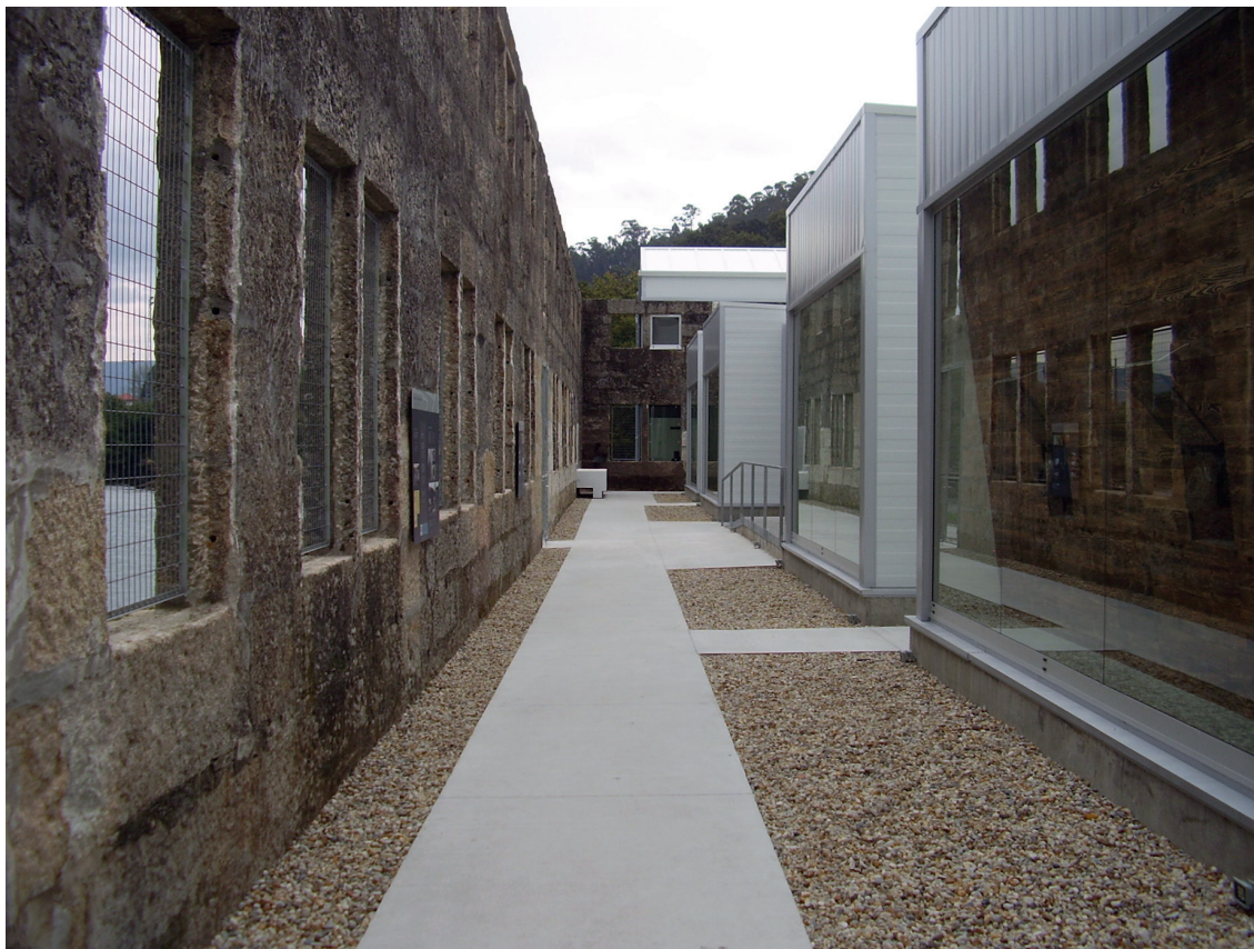
Figura 10. Vista interior da construción modular.
